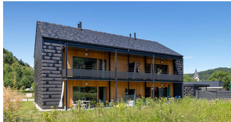
Logements sociaux bois-paille-passifs [88] © ASP Architecture & Terranergie
